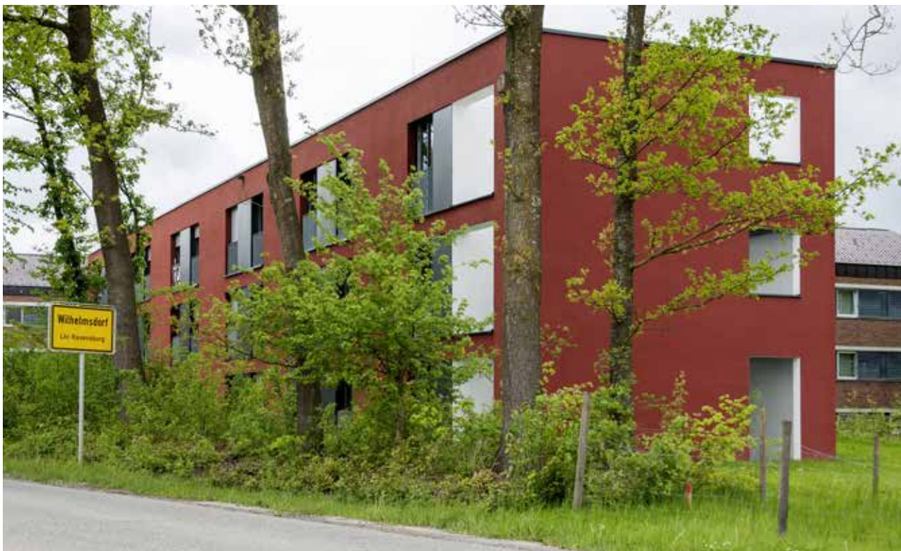
Neubau Haus Saar, Fachklinik Ringgenhof
